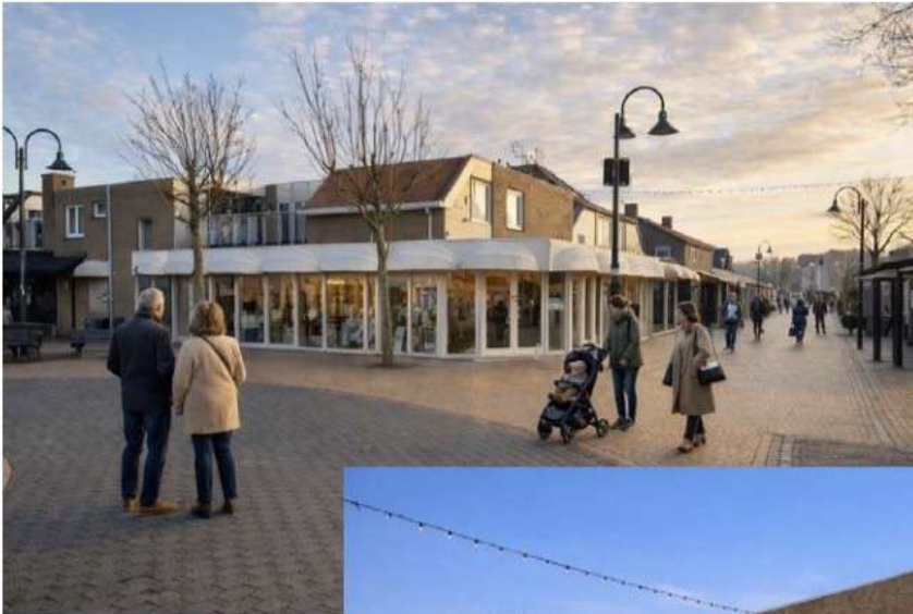
Hoek entree 141 plein / Dorpsstraat
