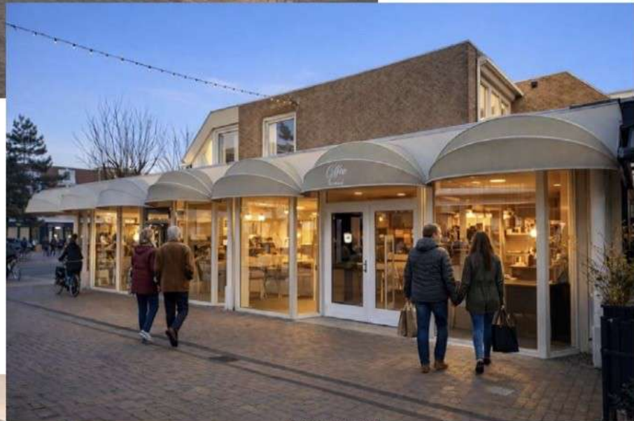
15 meter glazen pui + entree Dorpsstraat 143
